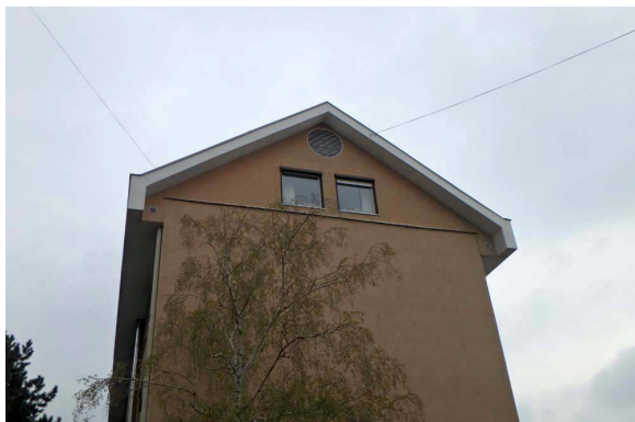
Nadstavba – štítová stena
