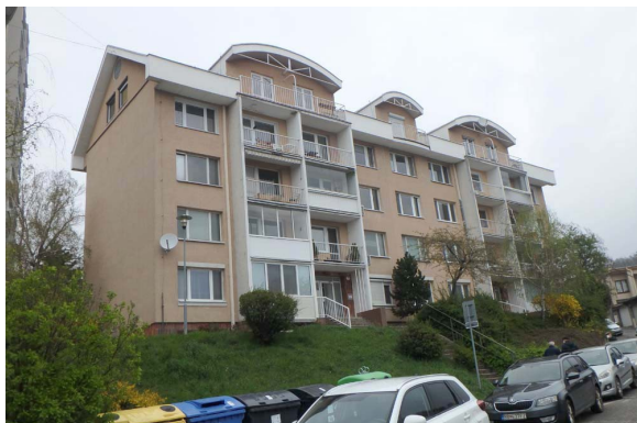
Pohľad na fasádu z ulice
