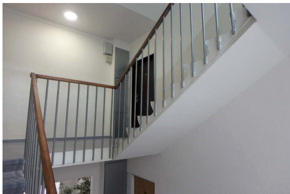
Schodisko 1.PP – 4.NP, Guothova 1
