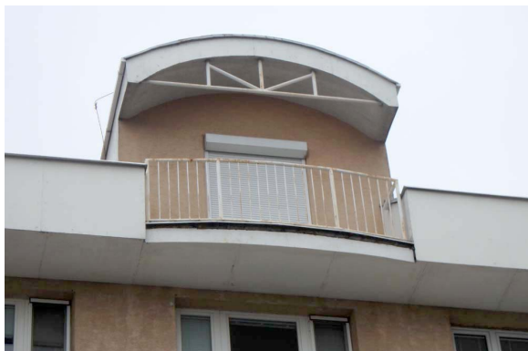
Nové oceľové balkóny 5.NP
