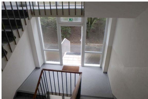
Schodisko 1.PP – 4.NP, Guothova 1
