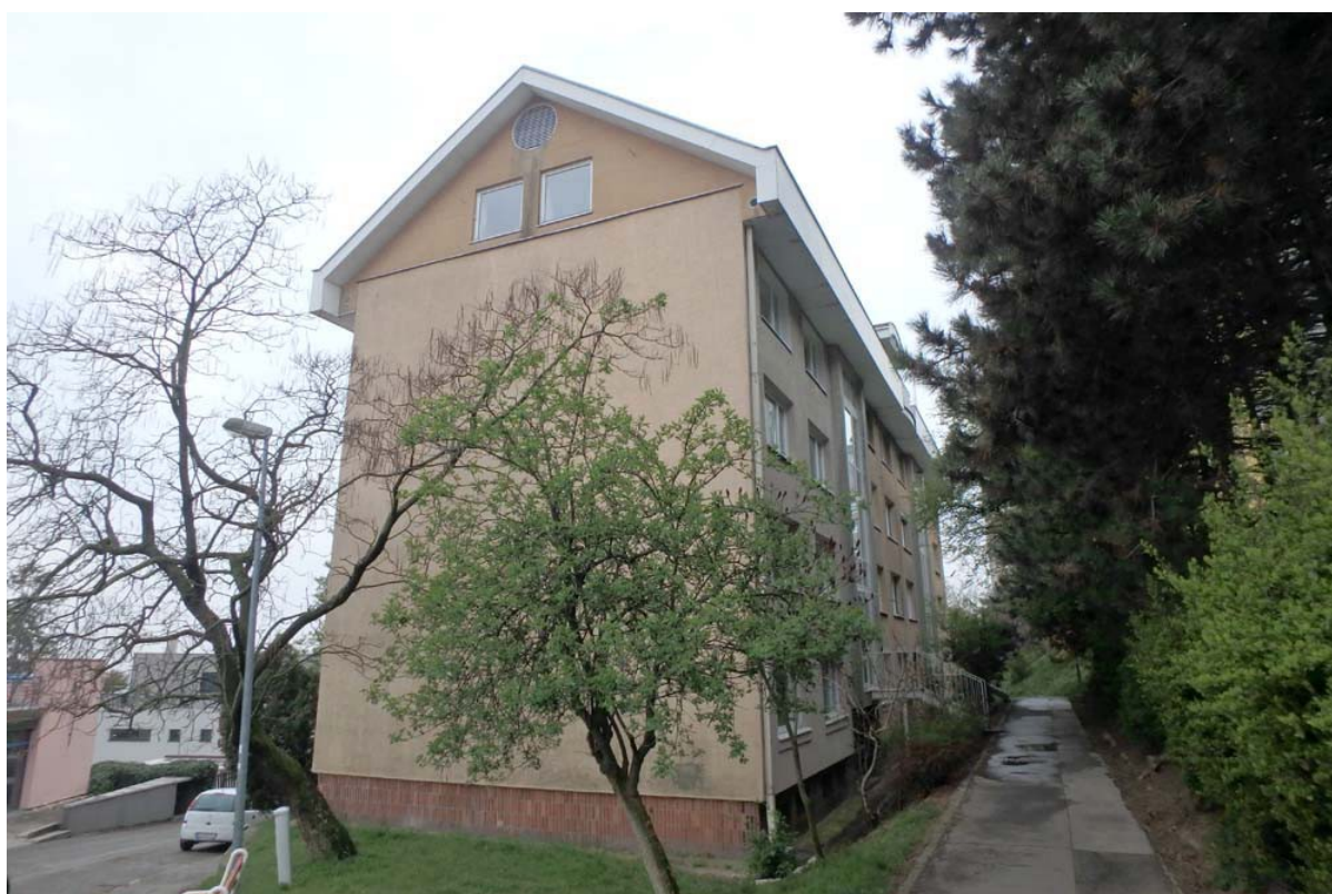
Bytový dom Guothova 1, 3, pohľad z dvora (vnútrobloku)
