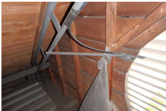
Nadstavba – štítová stena
