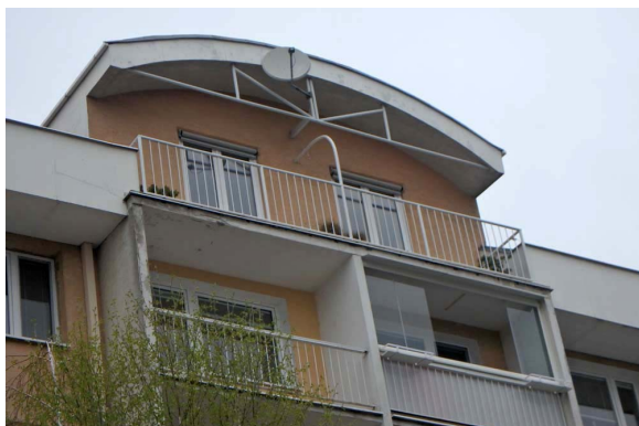
Nadstavba – vikiere s balkónom
