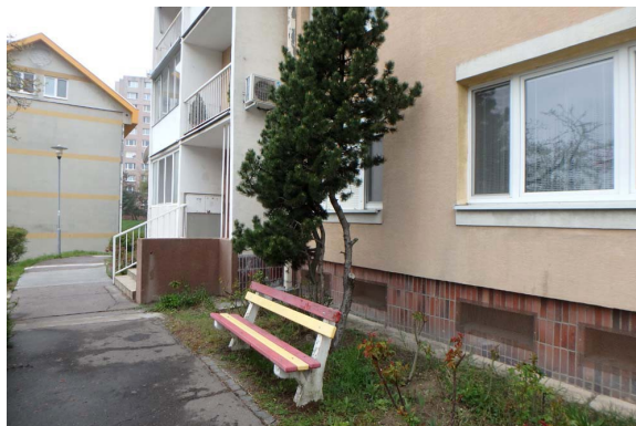
Pohľad na fasádu z ulice
