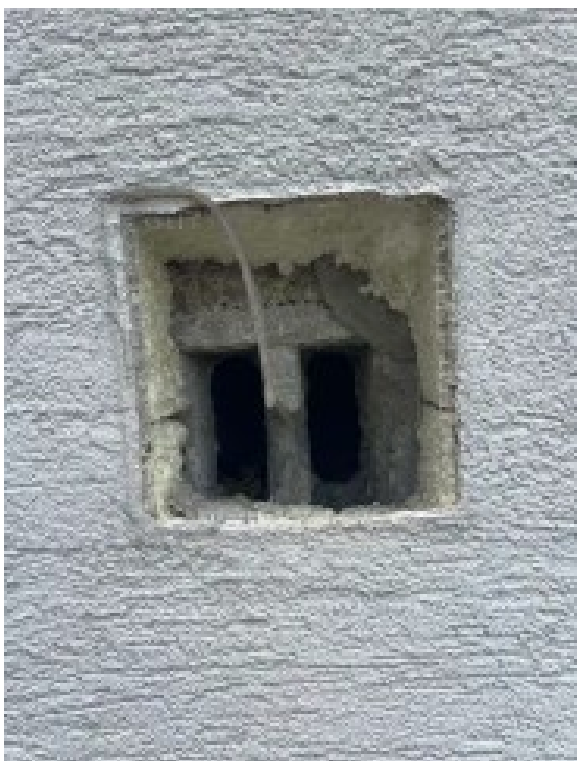
Poškodené, alebo chýbajúce vetracie mriežky a zle zrealizovaný vetrací otvor
