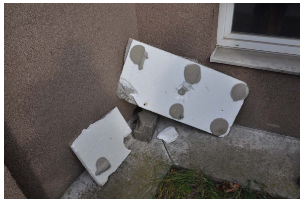
Stav zatepľovacieho systému ETICS, stav lepenia izolantu, stav kotvenia systému
