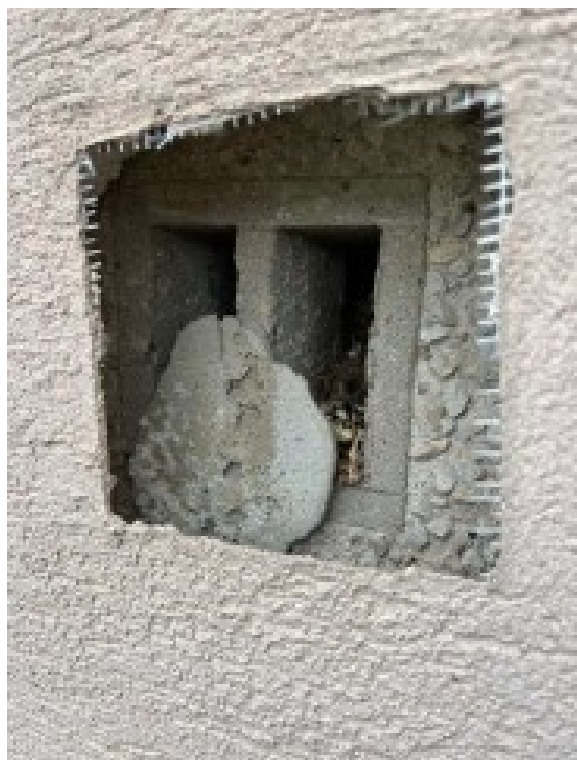
Poškodené, alebo chýbajúce vetracie mriežky a zle zrealizovaný vetrací otvor
