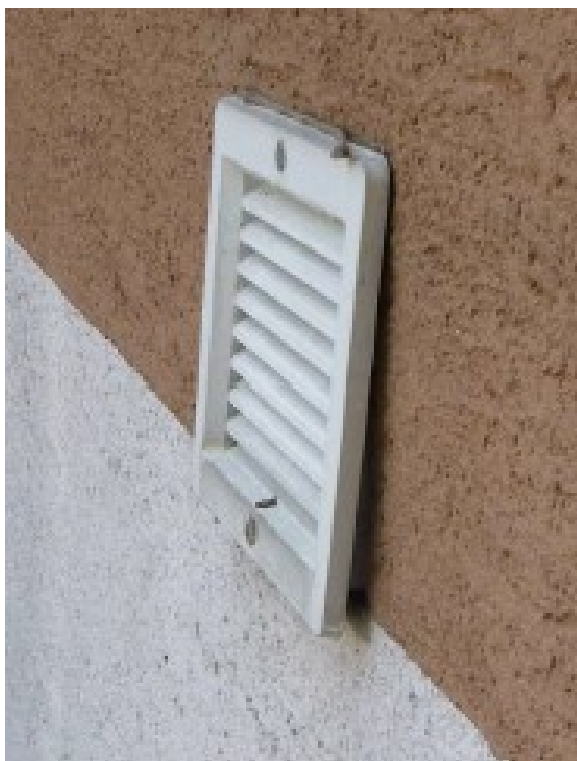
Poškodené, alebo chýbajúce vetracie mriežky a zle zrealizovaný vetrací otvor
