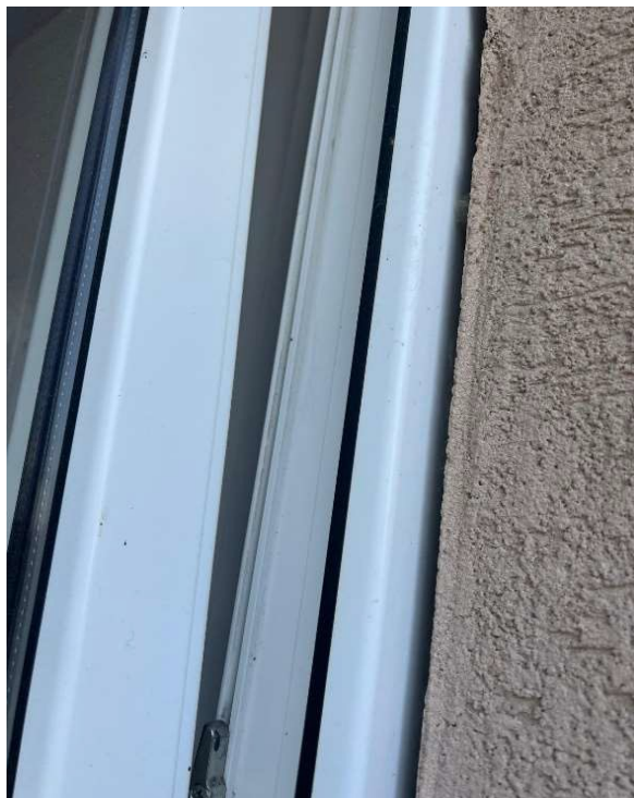
Škály po osadení okien
