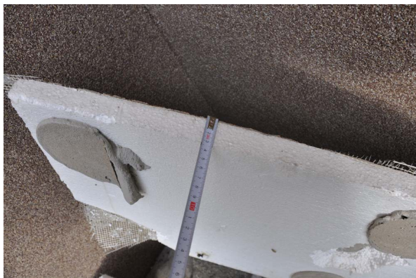
Stav zatepľovacieho systému ETICS, stav lepenia izolantu, stav kotvenia systému
