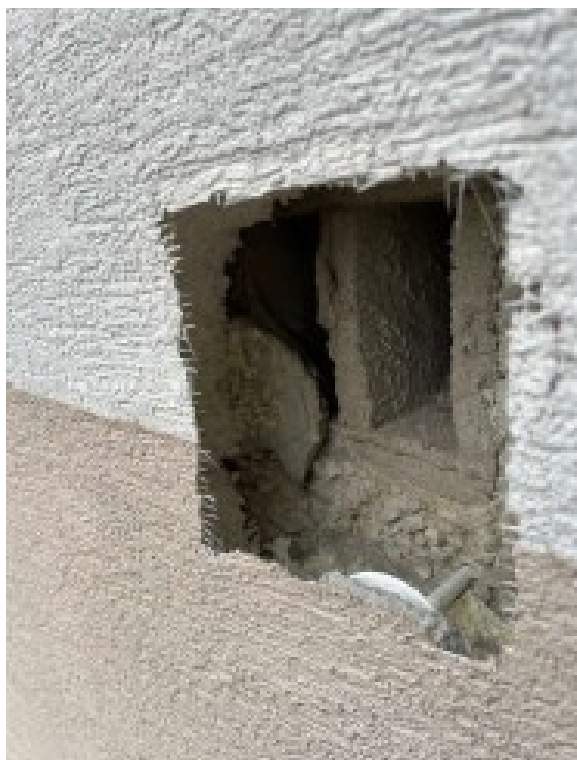
Poškodené, alebo chýbajúce vetracie mriežky a zle zrealizovaný vetrací otvor
