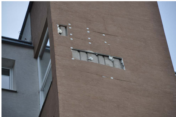
Bodrocká 18 miesto s najväčším poškodením zateplenia ETICS
