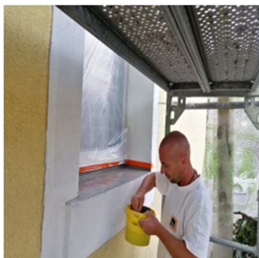
Aplikovať hydroizoláciu
