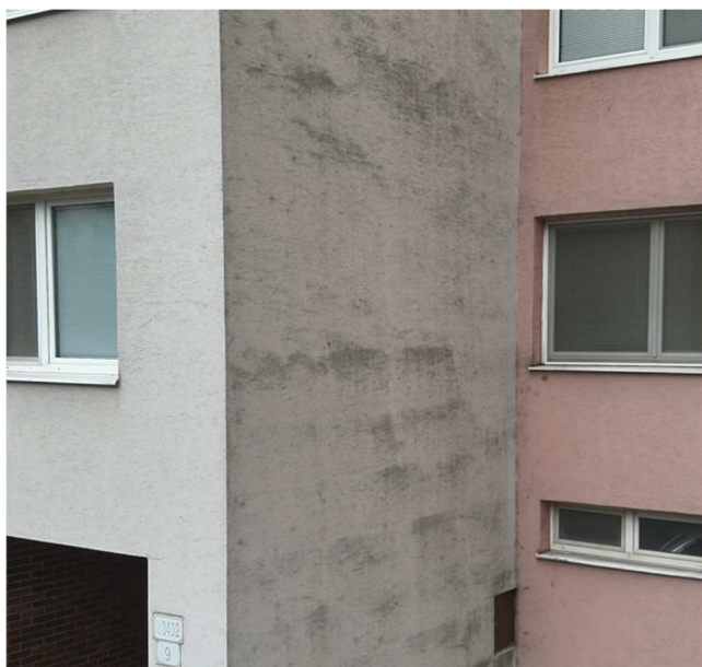
Znečistenie omietky, biotické napadnutie povrchu zateplenia riasami a machmi
