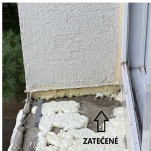
Demontovať parapet
