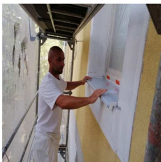
Osadenie nového parapetu
