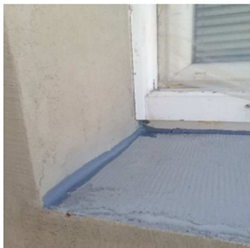
Vytmeliť pod parapetom
