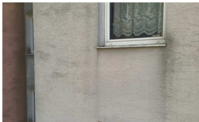
Znečistenie omietky, biotické napadnutie povrchu zateplenia riasami a machmi
